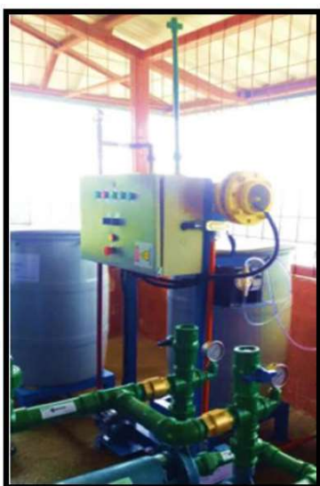
Ilustración 43: Sistema de desinfección con hipoclorito de sodio
