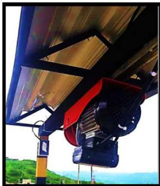
Ilustración 32: Sistema de izaje de cribas de aguas residuales
