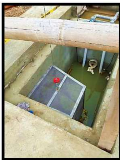
Ilustración 33: Cárcamo de bombeo de aguas residuales
