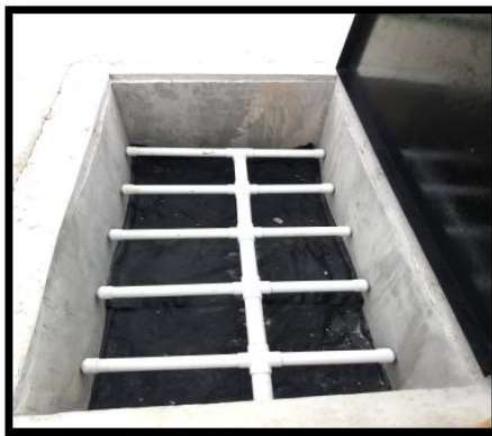
Ilustración 45: Lechos de secado
