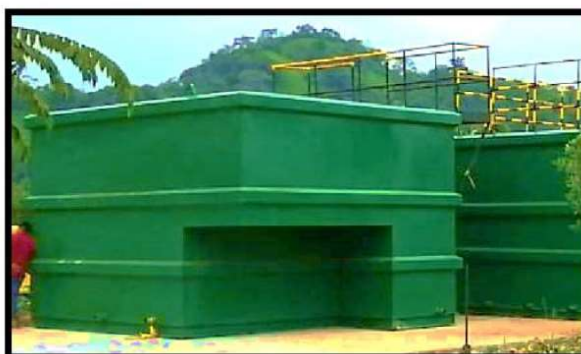
Ilustración 37: Reactor Biológico
