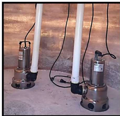
Ilustración 35: Sistema de bombeo de impulsión de aguas residuales
