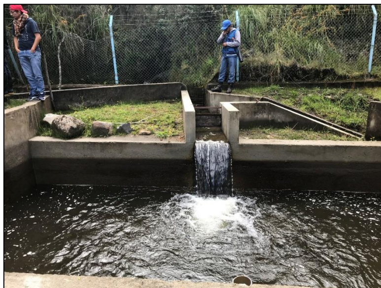
Fotografía 18 Caudal de ingreso después de limpiar la reja de entrada
