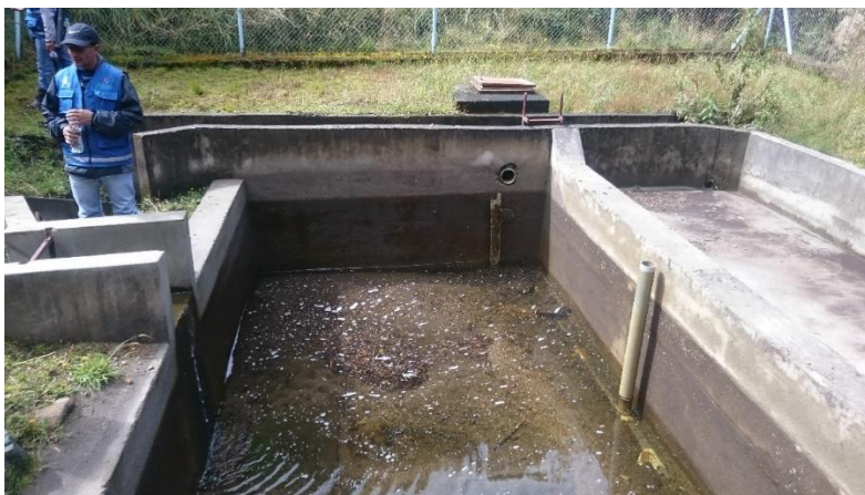
Fotografía 17 Bajo caudal de ingreso debido a la obstrucción de la reja de entrada
