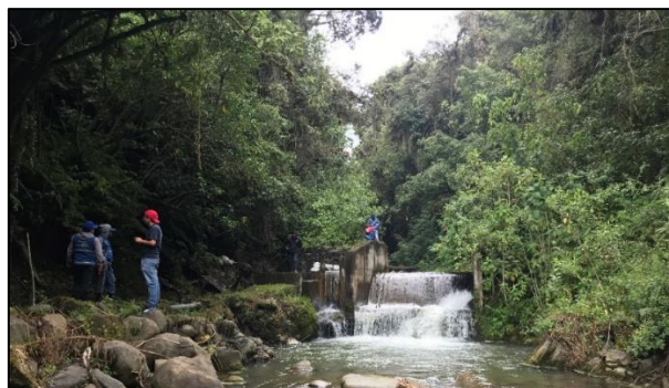
Fotografía 26 Dentellón provoca el efecto de un deflector de caudal
