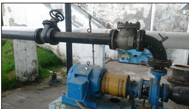
Fotografía 7 Bomba Goulds de 100HP conectada, pero sin funcionar
