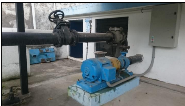
Fotografía 6 Bomba Goulds de 100HP conectada, pero sin funcionar.
