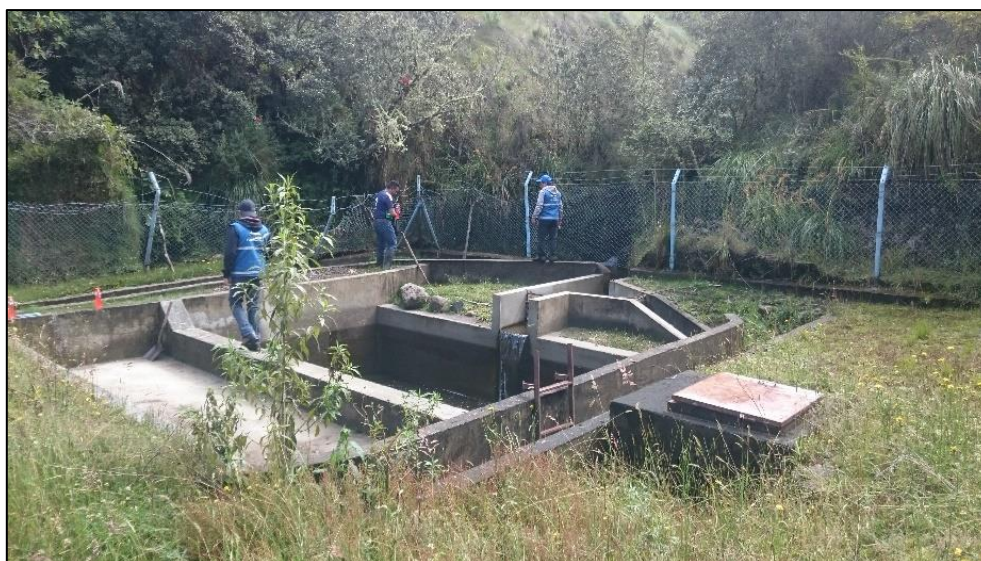
Fotografía 15 Captación de la fuente del sistema de abastecimiento Pinahurco
