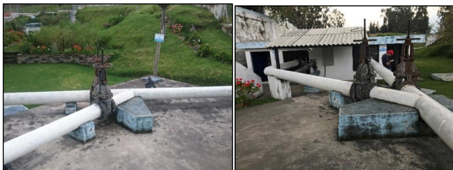
Fotografía 3 Válvulas de compuerta de los grupos de bombeo.
