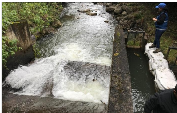
Fotografía 25 Azud de la captación desgastado
