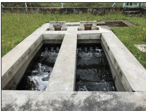
Fotografía 20 Tanque rompe presión del sistema Pinahurco
