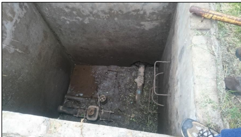
Fotografía 13 Acumulación de sedimentos en el sistema de purga de uno de los tanques de reserva en los Pinos
