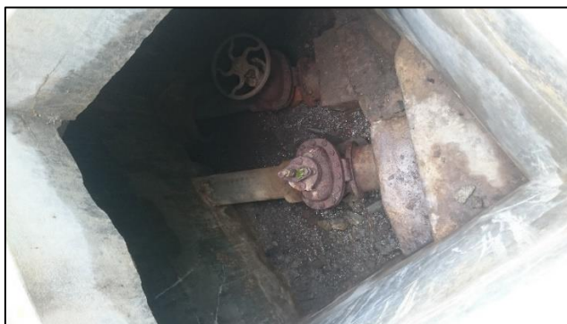
Fotografía 12 Válvulas de limpieza en las captaciones de Cariacu 1 en mal estado
