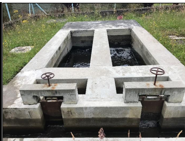
Fotografía 20 Tanque rompe presión del sistema Pinahurco
