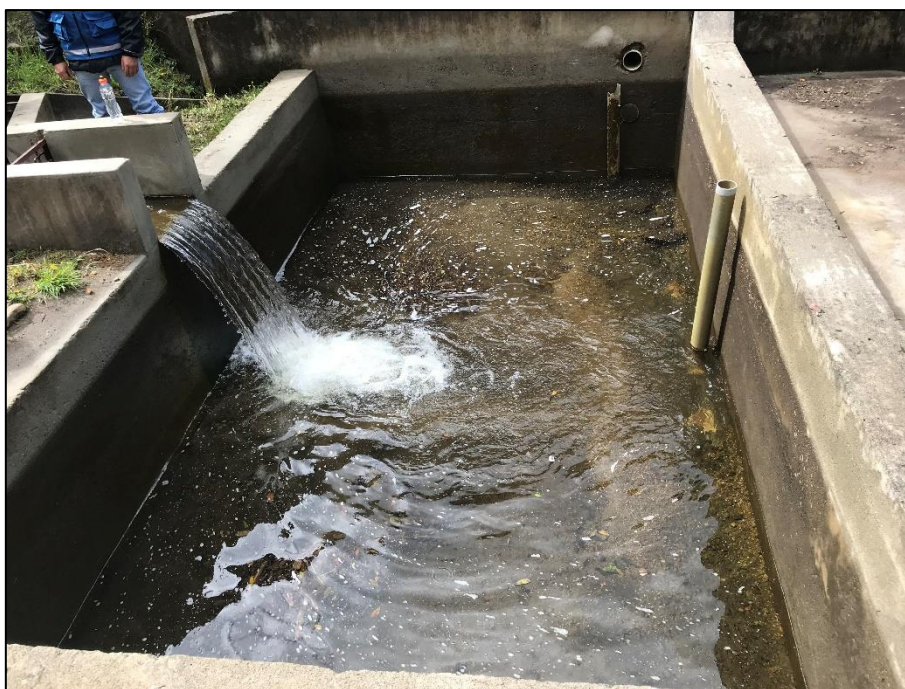
Fotografía 19 Tubos de PVC en mal estado, tapados de sedimento, sueltos
