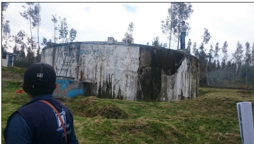
Fotografía 14 Tanque de reserva Los Pinos, 250m 3 de capacidad, paredes con filtraciones
