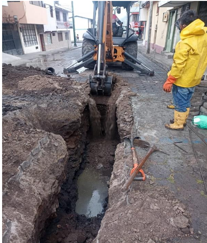
Fotografía 1: Mantenimiento de la red de alcantarillado por colapso Calle Libertad entre Olmedo y Juan Montalvo.
