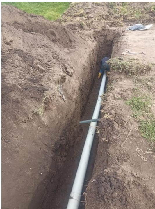
Fotografía 4: Instalación de acometida domiciliaria Sector La Remonta.
