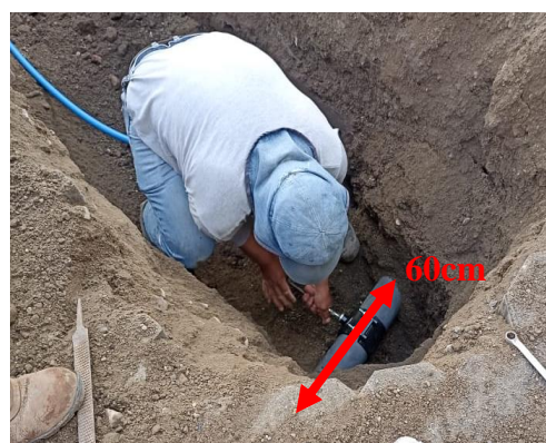
Ilustración 2. Ancho de la zanja (60 cm)
